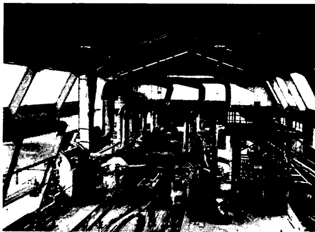
Ventilation aspirante dans des installations au jour.
