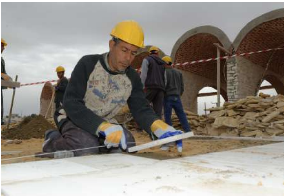
► Chantier école de construction
